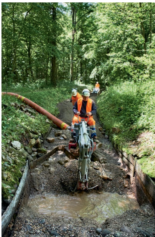
Der Ersatz der Sickerkiessschichten erfolgte so schonend wie möglich für die Anlagen und den Waldboden.
